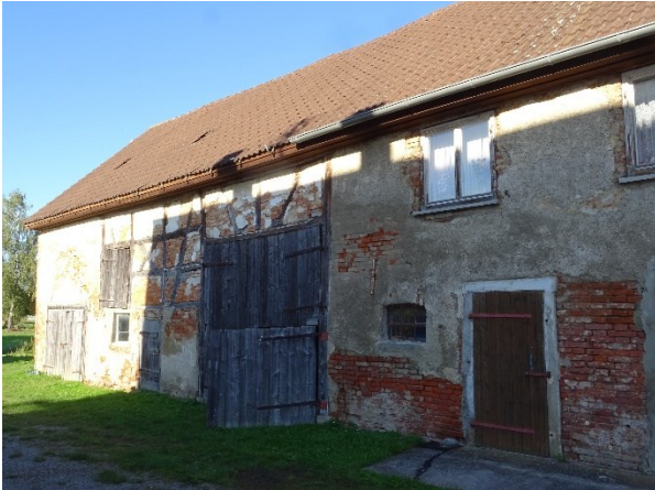
Der rückwärtige Stadel soll abgebrochen werden. Westseite, Blick von Süden ...
