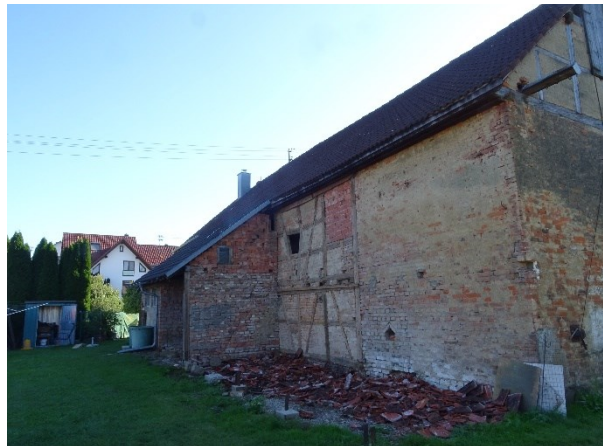
Dto., Ostseite. Das Schleppdach wurde hier schon abgebrochen, dadurch ist eine Art „Fenster“ in den Stadel freigelegt worden.
