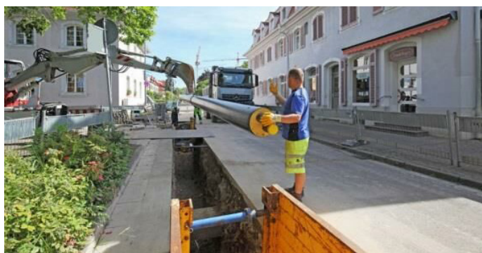
Errichtung eines Wärmenetzes in St. Peter im Schwarzwald. Foto: KEA-BW / triolog
